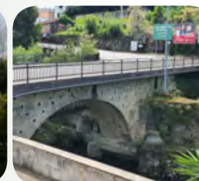
Ponte de Santana
