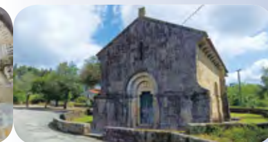
Mosteiro de Arnoso, Arnoso Sta Eulália
