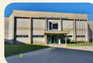
Pavilhão Municipal das Lameiras, Antas
