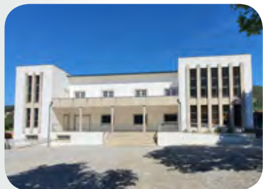
Centro Paroquial, Telhado
