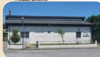
Edifício da Junta de Freguesia, Mouquim
